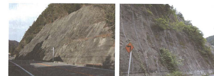
モルタル吹付法面の施工事例
