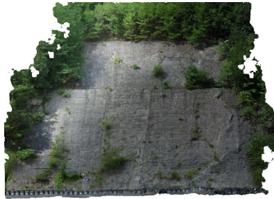
斜面Bにおけるひび割れ調査
