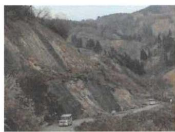
写真 3.7.3 吹付けのり面の崩壊(中越地震)
