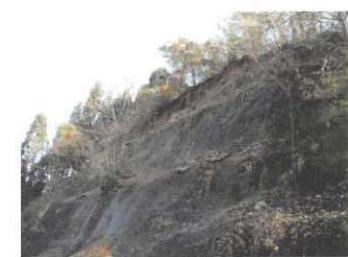
写真 3.7.4 吹付けのり面の崩壊(中越地震)
