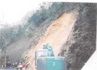
写真 3.7.2 吹付けのり面の崩落(芸予地震)\*
