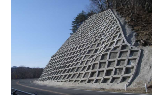
対策後の法面
