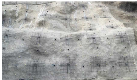
受圧板専用の補強部材の設置
