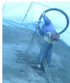
繊維補強モルタル吹付
